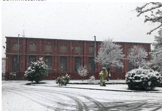
Facciata principale del Fabbricato ART (Nord-Est)
