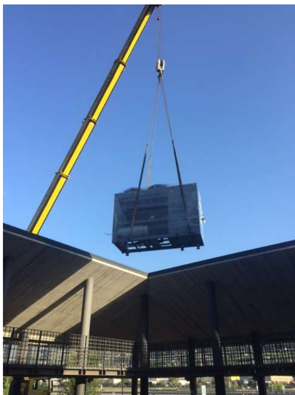
Fase di posa della macchina frigorifera.
