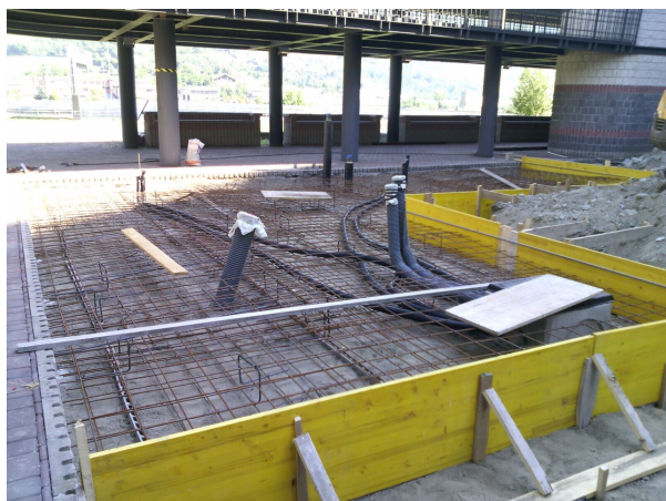
Fase pre-getto del basamento in c.a. esterno
