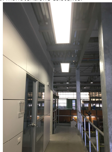
Corridoio di accesso agli uffici al piano primo
