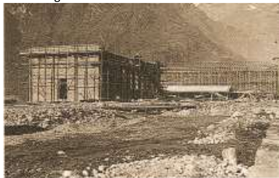
Costruzione del Fabbricato “ART”
